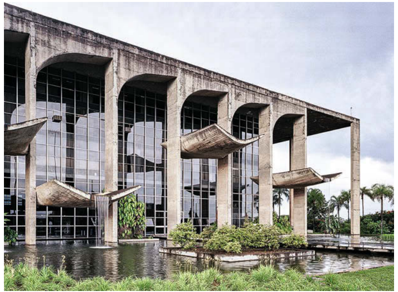
Von Glas und Wasser umspielt: Ministerio de Justicia (8) · Wrapped in glass and water: Ministério da Justiça (8)
