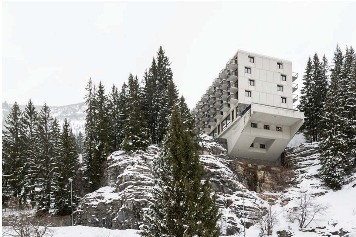
Spektakulärer Überhang: Hotel Le Flaine - 1968 erbaut und 2019 komplett renoviert. • Spectacular: Hotel Le Flaine - built 1968, refurbished 2019
