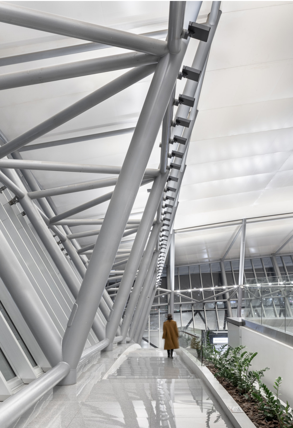
Im Innenraum ersetzen Lightscan LED-Schein- werfer die alten Parscoop Fluter zur indirekten Beleuchtung. Energieeinsparung: 65%
